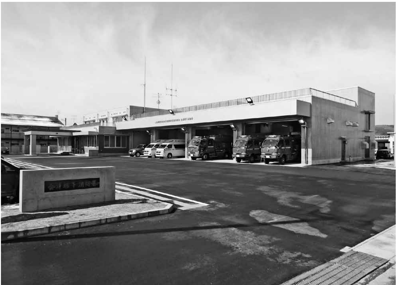
【会津坂下消防署新庁舎（平成30年度完成）】
