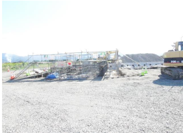
10月7日 新庁舎ピット部ベース基礎工事・訓練塔の地足場組立
