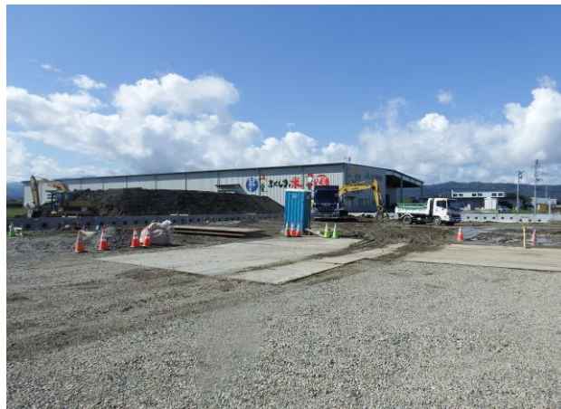
10月14日 新庁舎ピット部ベース基礎工事
